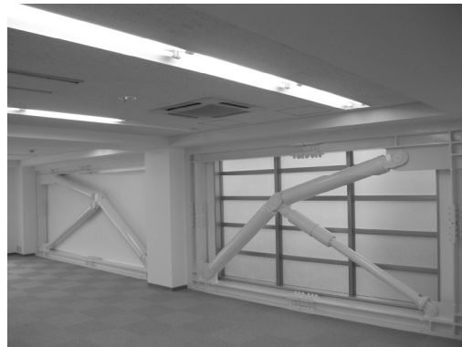
写真-2 Fビル装置設置後
