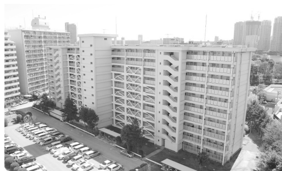
写真-1 架構増設型トグル制震補強の例
