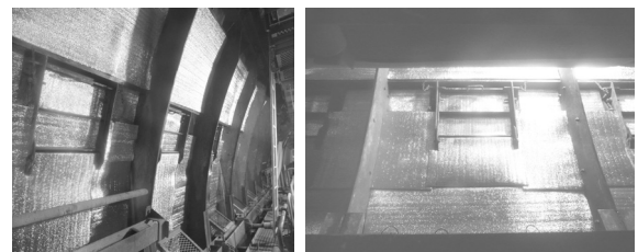
写真-1 アルミマットを用いたセントル養生
