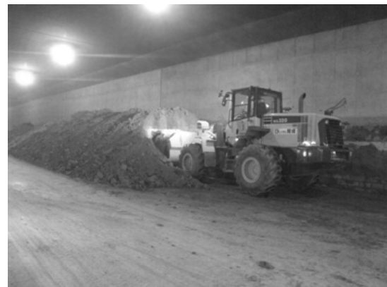
写真-6 既設ボックス内のずり仮置き場
