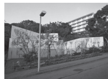
写真-2 貯水関係施設
