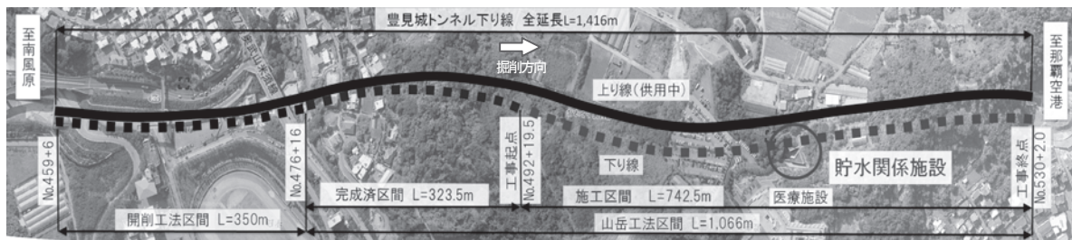
写真-1 トンネル施工場所の航空写真
