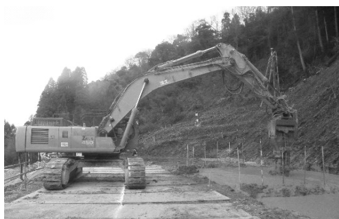
写真-1 パラレル工法施工状況
