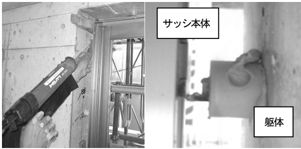
写真-3 樹脂剤注入
