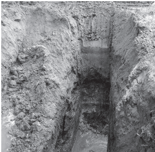
写真-1 油汚染状況（地下水面に油膜発生）
