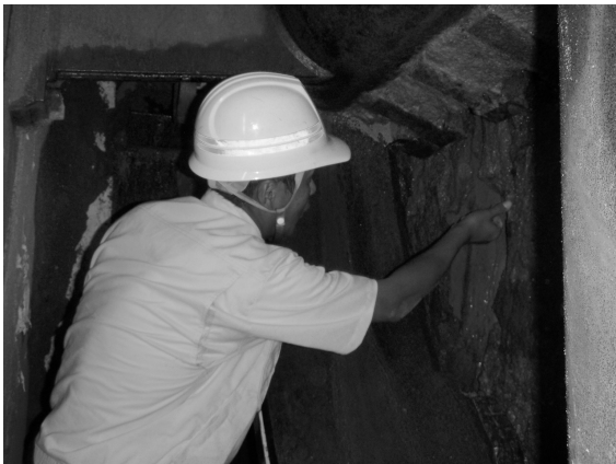
写真-2 岩盤層確認
