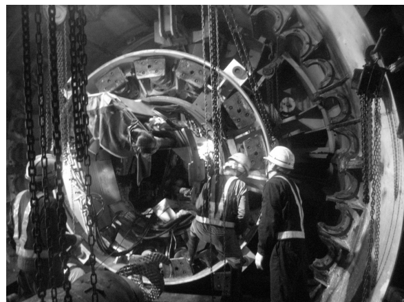
写真-6 子機胴体組立
