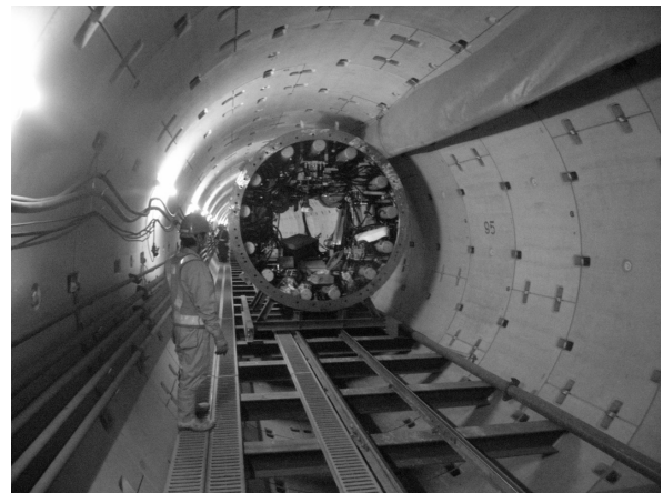
写真-5 子機中胴坑内運搬
