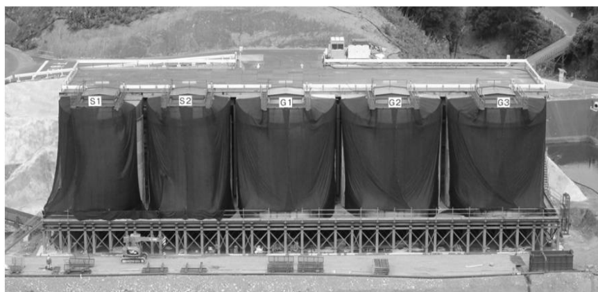
写真-1 遮光ネット設置状況
