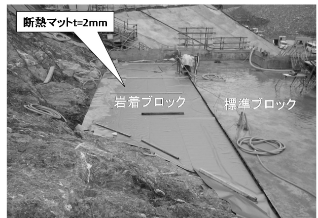
写真-6 岩着部湛水養生状況
