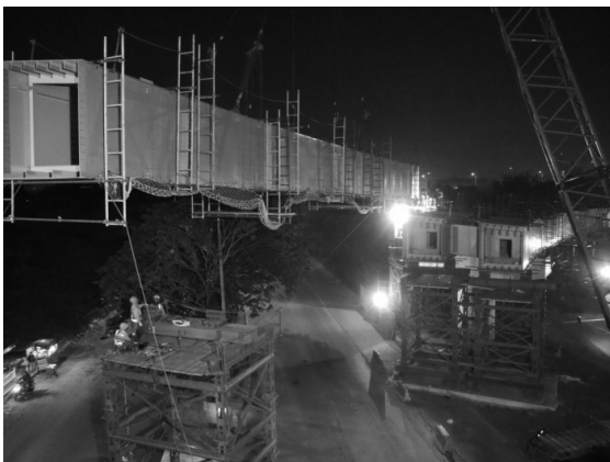
写真-5 鋼製箱桁の架設状況
