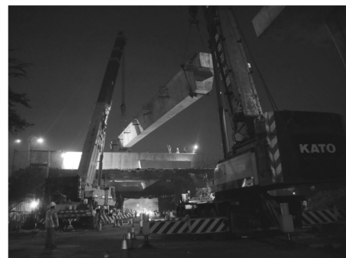
写真-4 PC-U桁の架設状況
