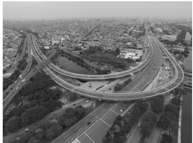
写真-6 工事竣工全景 2015年12月
