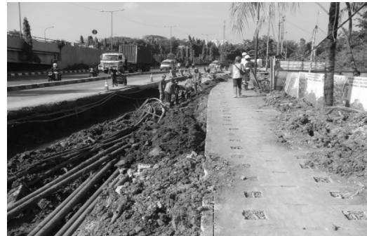
写真-1 気泡コンクリート準備状況 (既設国道の拡幅工事)
