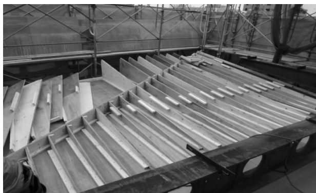
写真-3 櫛型柱 (櫛型取付け施工中)
