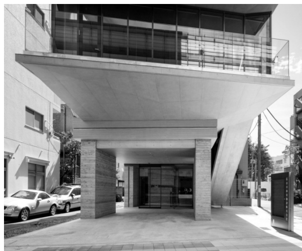
写真-5 勾配スラブ上裏 (ピロティ正面)
