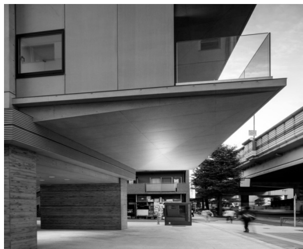
写真-6 勾配スラブ上裏 (ピロティ側面)
