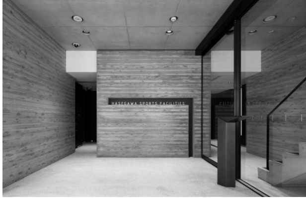
写真-8 本実型枠打放し柱・壁（エントランスホール）
