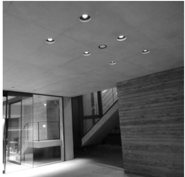
写真-16 ピロティ天井のDL照明 (DL等は予めスラブ型枠にスリーブを設置)
