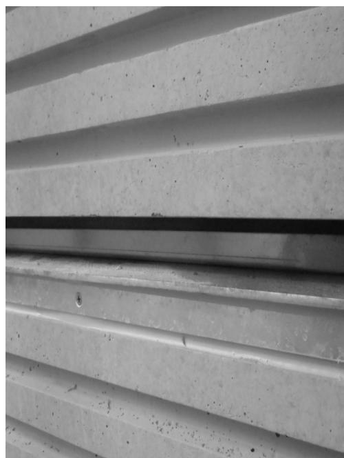
写真-2 免震スリットの外観
