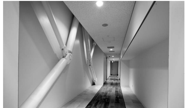
写真-10 トグル制震装置
