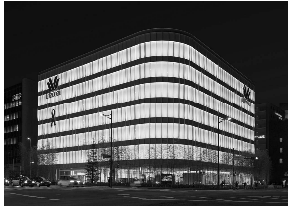
写真-4 建物外観 (夜間：北西面)
