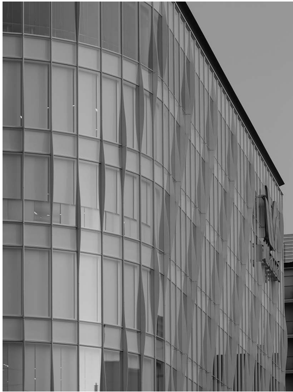
写真-3 三次元フィン (カーテンウォール)
