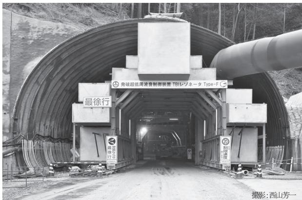
写真-1 消音装置設置状況
