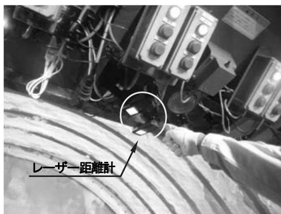
図-9 切羽監視システム（レーザー距離計）
