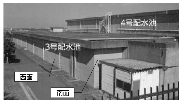
写真-1 配水池外観
