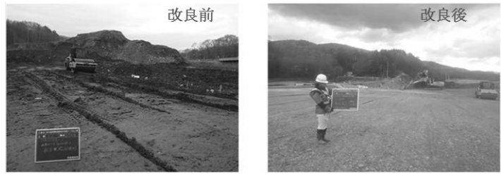
写真-1 改良前と改良後の盛土モデル施工状況
