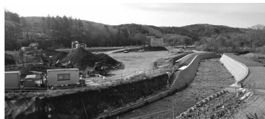
写真-2 万能改良システム及び本線盛土全景
