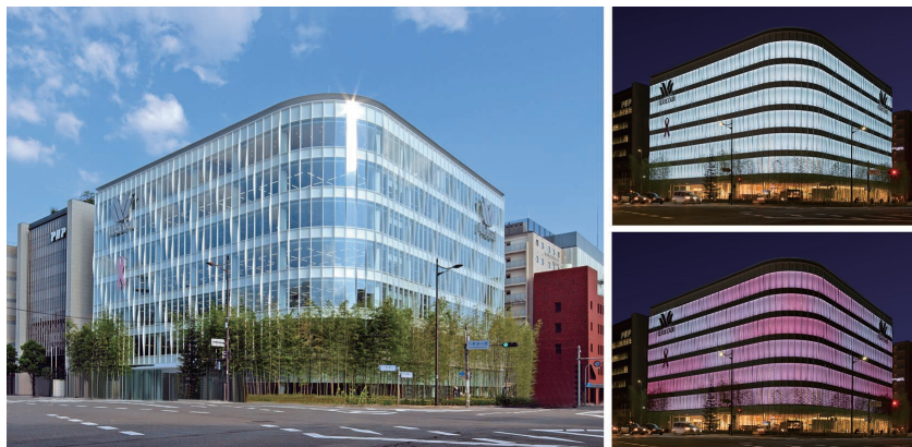
建物外観（北西面、左：昼間、右：夜間）
