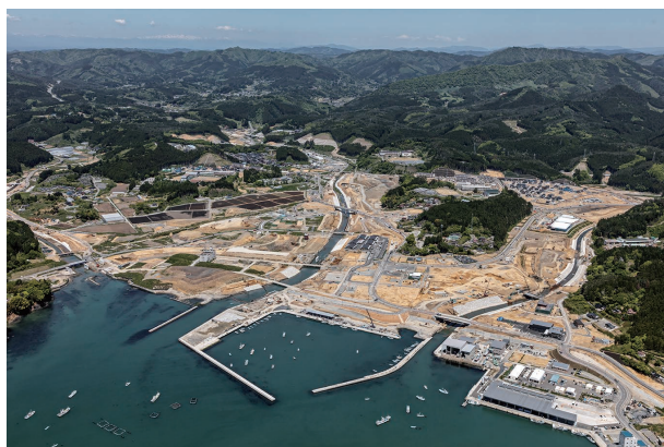
南三陸町盛土状況
