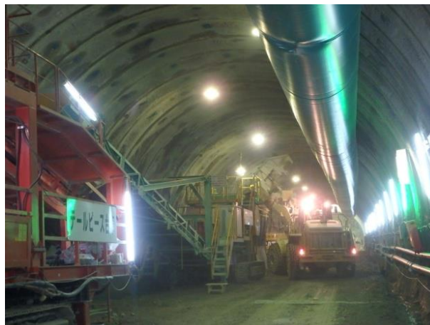
クラッシャー投入状況
