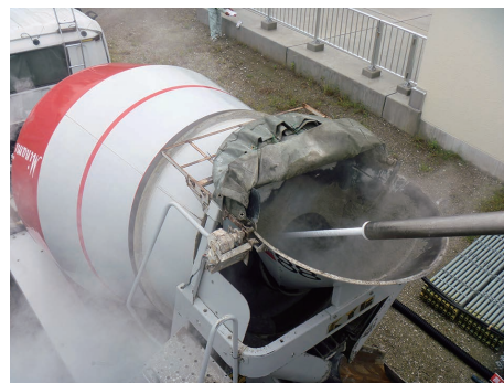
液体窒素投入状況
