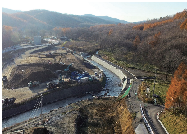
河川付替工、本線盛土工の状況 中央（青い機械）は万能土質改良システム
