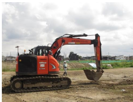
バケットによる地表面叩き状況
