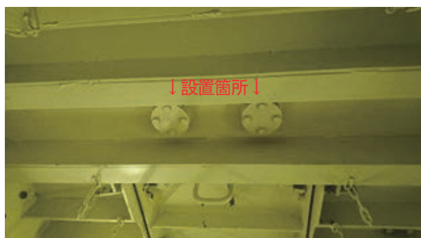
写真-4 センサ設置箇所（設置前）
