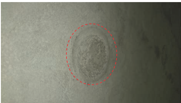
写真-7 脱枠後の測定箇所（覆工コンクリート）
