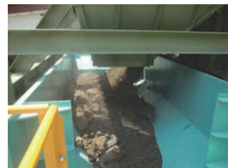
写真-2 クラッシャホッパー内部（改造前）
