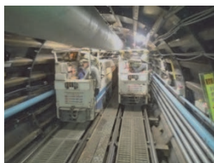
写真-11 2,600m地点の離合箇所
