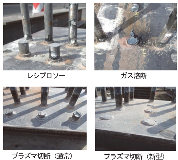
写真-8 スタッド切断・仕上げ状況の比較
