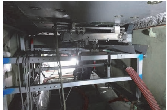
写真-2 移動架台付き WJ 削孔装置
