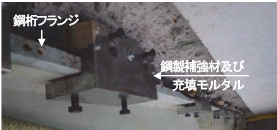
写真-5 仮補強の設置状況
