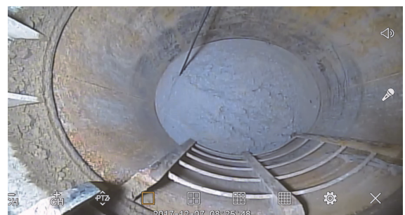
写真-5 断気24時間後のスラブシャフト内の状況
