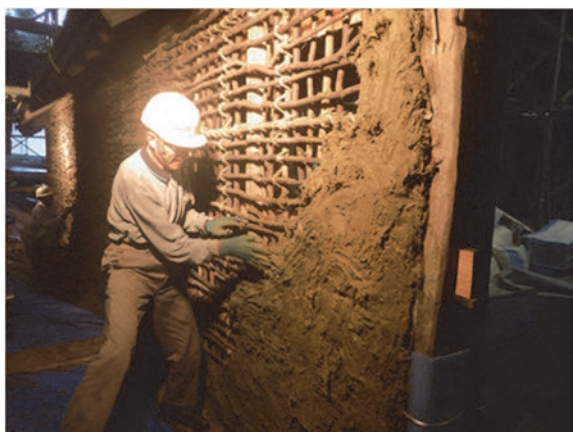
写真-3 粗梁木舞への壁土塗状況
