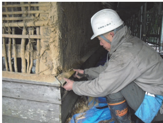
写真-2 解体工事（外壁腰見切解体）
