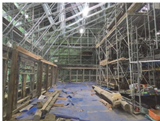
写真-1 解体工事（屋根架構の撤去）
