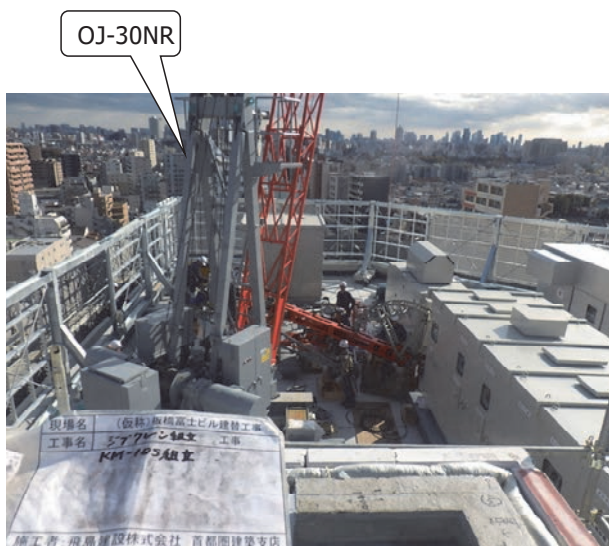
写真-14 ジブクレーン (KM-10S) 組立状況
