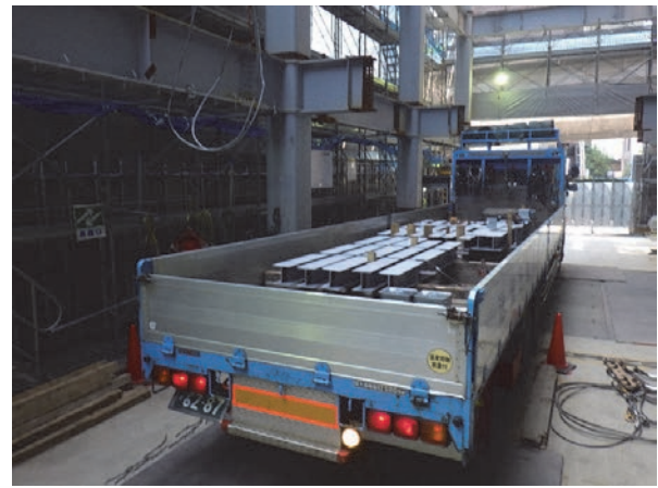
写真－11 資材搬入, 梁の間引き状況
