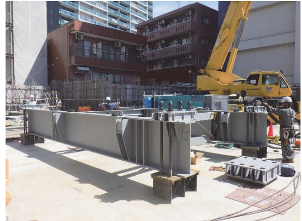
写真-6 タワークレーン基礎設置
