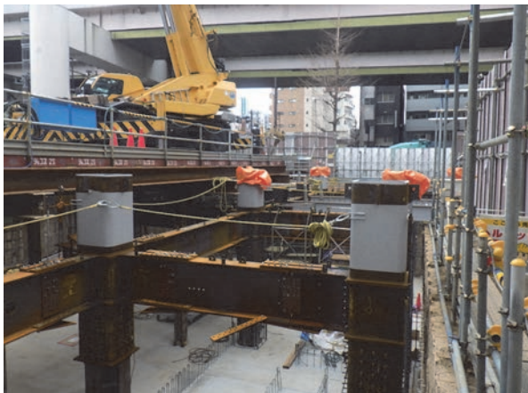
写真-5 0節鉄骨建方完了
