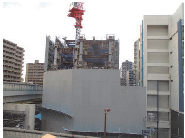
写真－10 5節鉄骨建方
