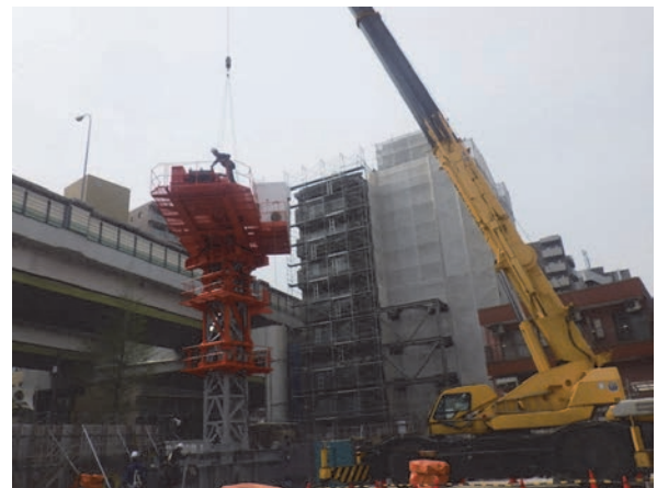
写真-7 タワークレーン組立状況
