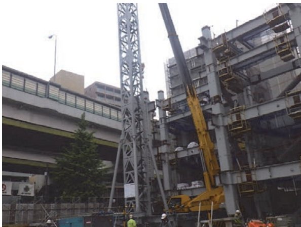
写真－9 ラフタークレーンによる鉄骨建方
