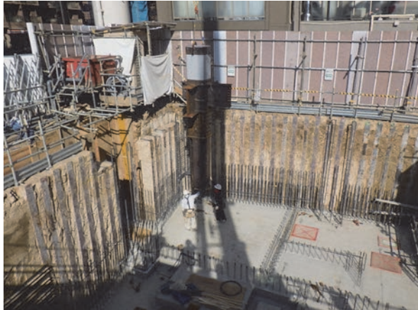
写真-3 0節鉄骨建方状況
