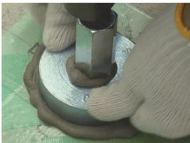
写真—1 無機系接着剤充填後、ディスクシアキー定着状況
