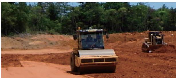
写真-3 ICT振動ローラによる丁張レスでの施工
