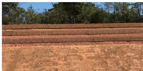
写真－8 上部法面のシガラ工施工状況
