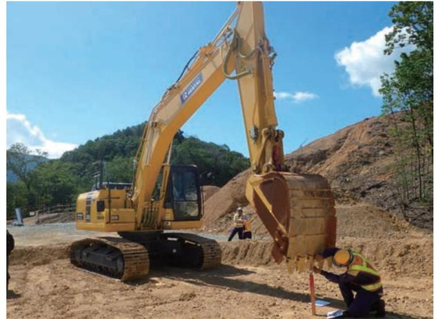
写真-4 基準杭による精度確認状況（バックホウ）
