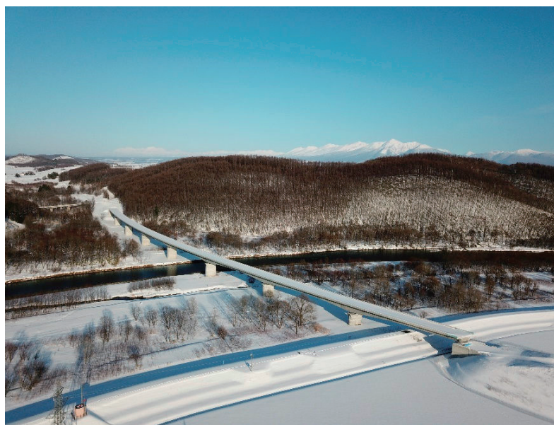
写真-3 新富良野大橋B橋竣工写真
