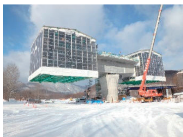
写真-1 超大型仮囲い
