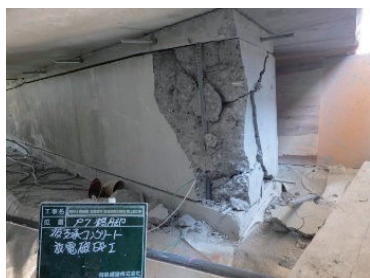
写真-2 放電破碎状況
