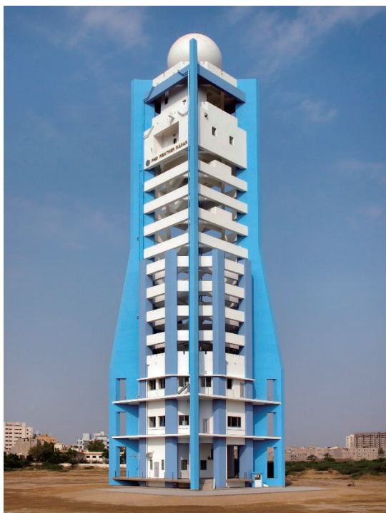
写真-1 完成写真
