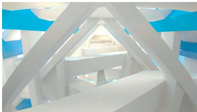
写真-2 建物内部（見上げ）
