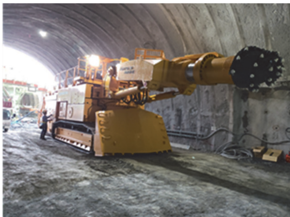
写真-2 搬入時の掘削機(ヘッド)
