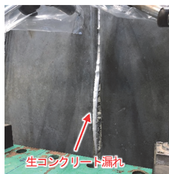
図-7 打設終了後の埋設型枠間
