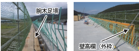
写真-1 一般工法による壁高欄施工状況
