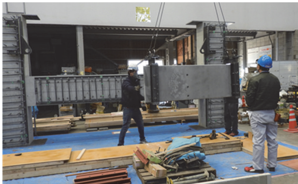
写真-6 梁外殻 PCa 部材吊込み状況
