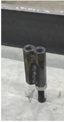
写真-4 仮設引張アンカー台直し状況
