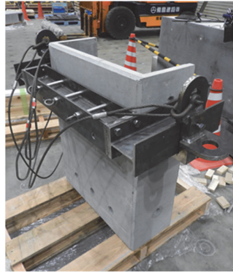
写真-5 柱外殻 PCa 部材吊冶具取付状況
