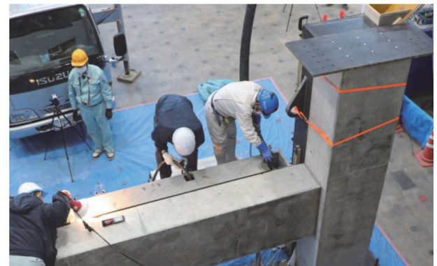
写真-9 梁側内部コンクリート打設状況
