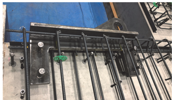
写真-3 内部鉄筋等配筋状況
