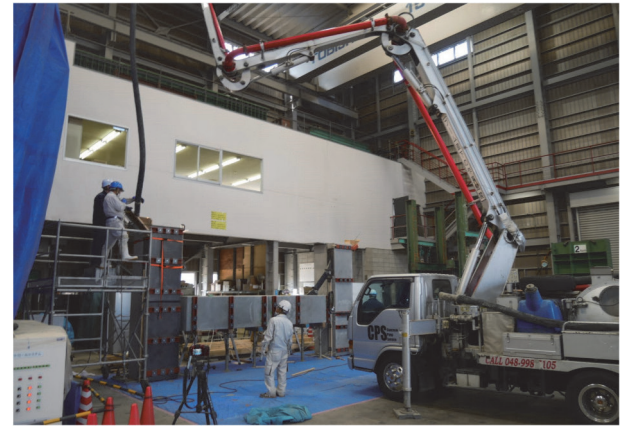
写真-8 柱側内部コンクリート打設状況
