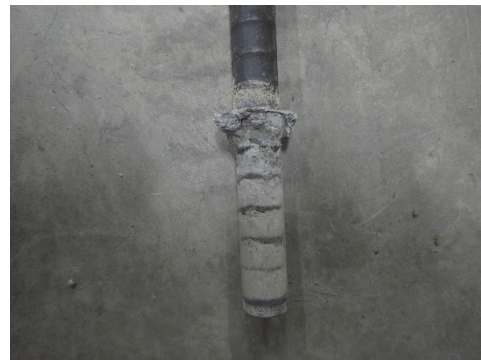
アンカー筋と「セメフォースアンカー寒冷地仕様」の界面での付着破壊 写真-3 最終破壊状況
