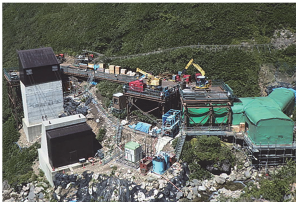
写真-1 仮設備ヤード全景
