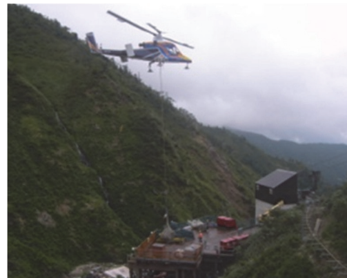
写真-2 ヘリコプターによる運搬状況
