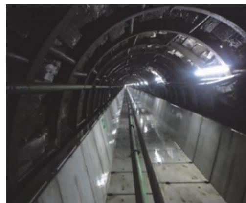
写真-4 プレキャスト水路施工完了
