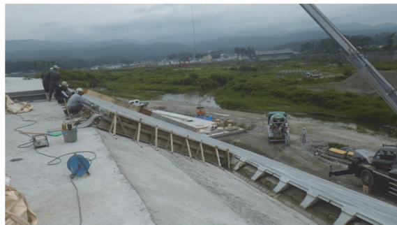
写真-2 裏法被覆工（胴込めコンクリート打設状況）
