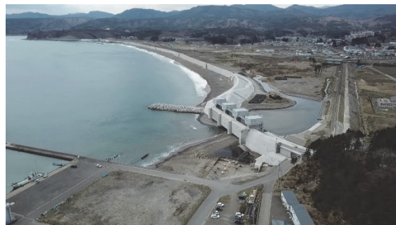
写真-4 竣工写真
