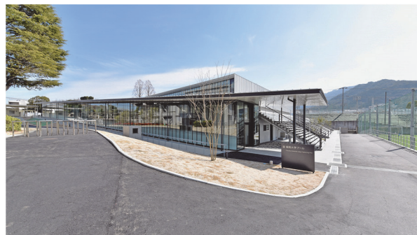
写真-2 竣工写真
