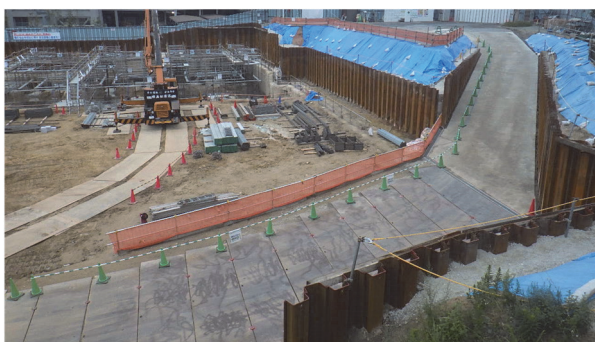
写真-1 仮設スロープ
