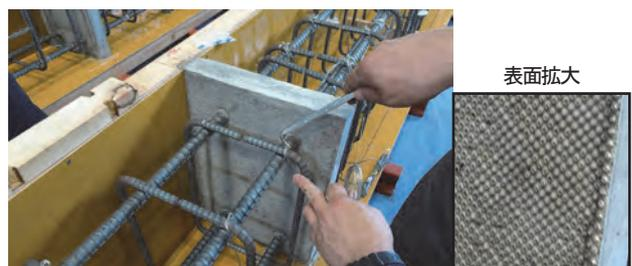
写真-1 プレキャスト部材の設置状況
