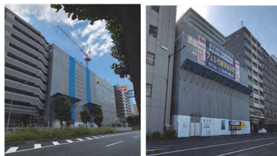
横浜市道側 国道16号側 写真-1 幹線道路から見た工事中の作業所全景
