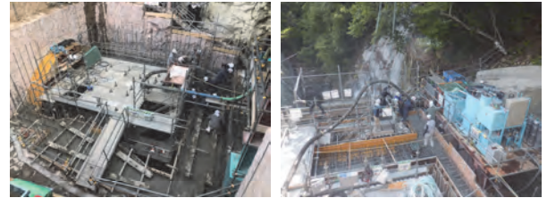
3リフト 9リフト 写真-5 コンクリート打設状況
