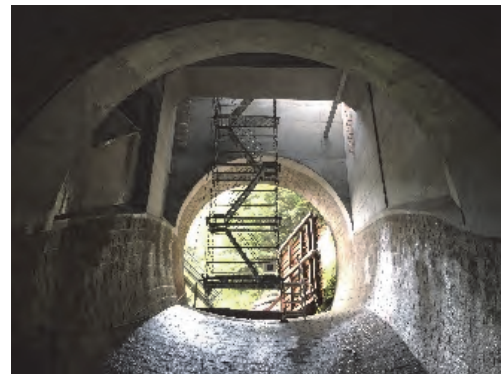
トンネル下流より
