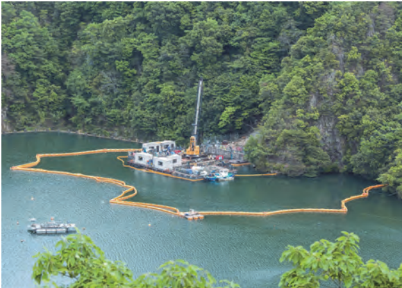
写真-2 クレーン台船作業状況
