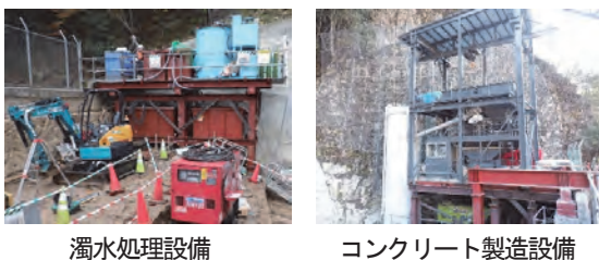
写真-3 仮設備設置状況
