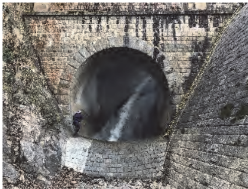
トンネル上流より
