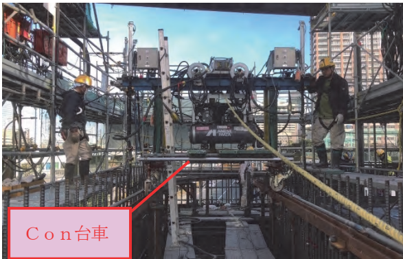
写真-3 コンクリート自動締め台車
