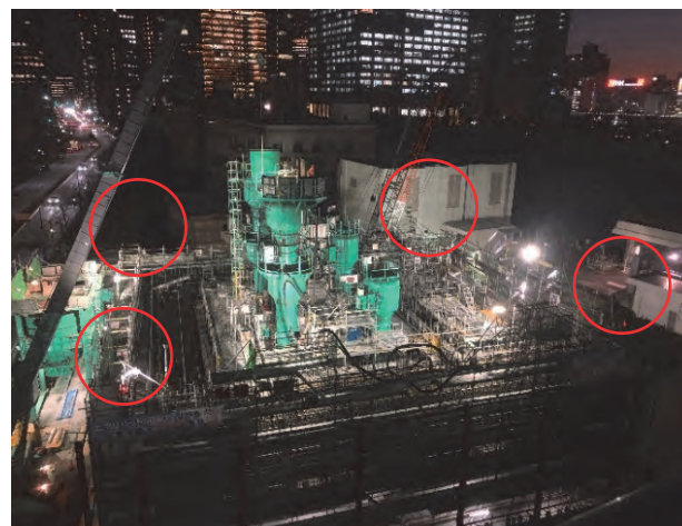
写真-1 足場上回転灯（4灯）表示
