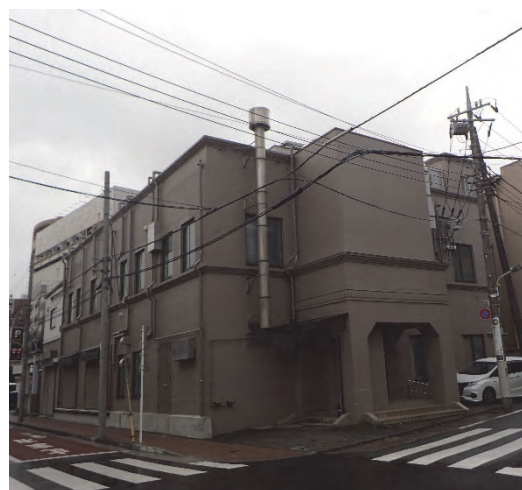
写真-1 対象建物の外観 (2021/8/17南東から撮影)
