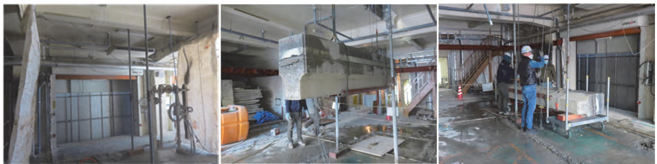
写真-3 ワイヤーソーによる部材切断
