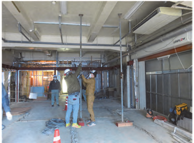
写真-2 スラブ保持のためのサポート設置作業
