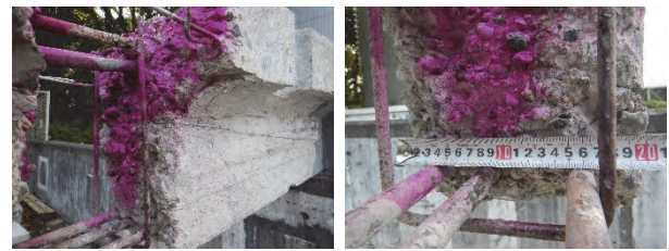
写真-6 コンクリートの中酸化深さ測定
