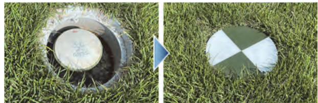
図-6 GNSS 柵ふた上部の塗色状況
