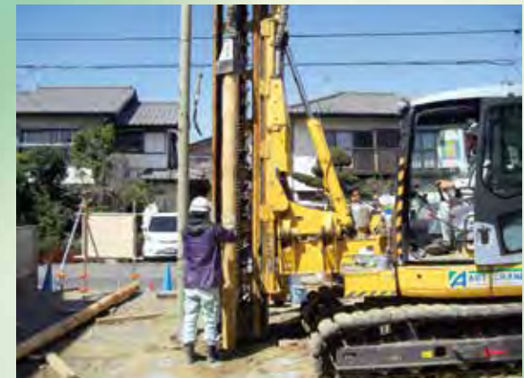
千葉県浦安市美浜3丁目(戸建住宅)
