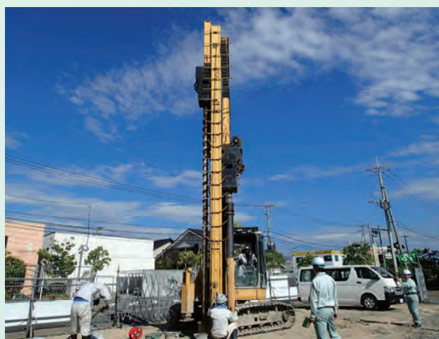
写真-1 施工状況
