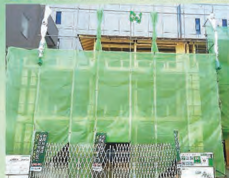
センサー設置後の3階建て戸建て住宅の建設状況
