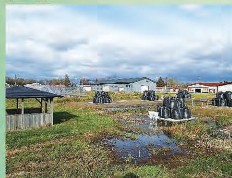
色々な条件で丸太打設による地盤対策を行い長期沈下観測
