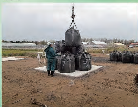
丸太を打設し改良した地盤に住宅基礎を施工し錘を載荷
