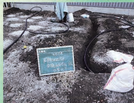
地震時の液状化計測用センサーの埋設状況
