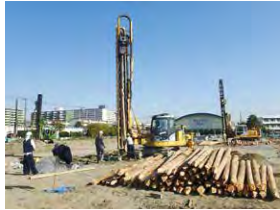
大規模分譲住宅における施工
