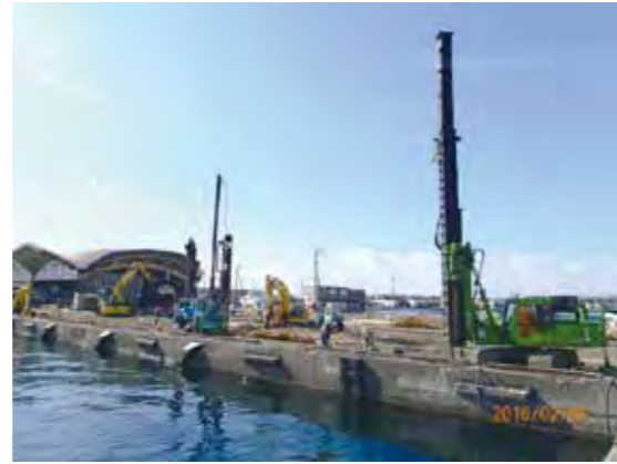
漁港の耐震強化岸壁における施工
